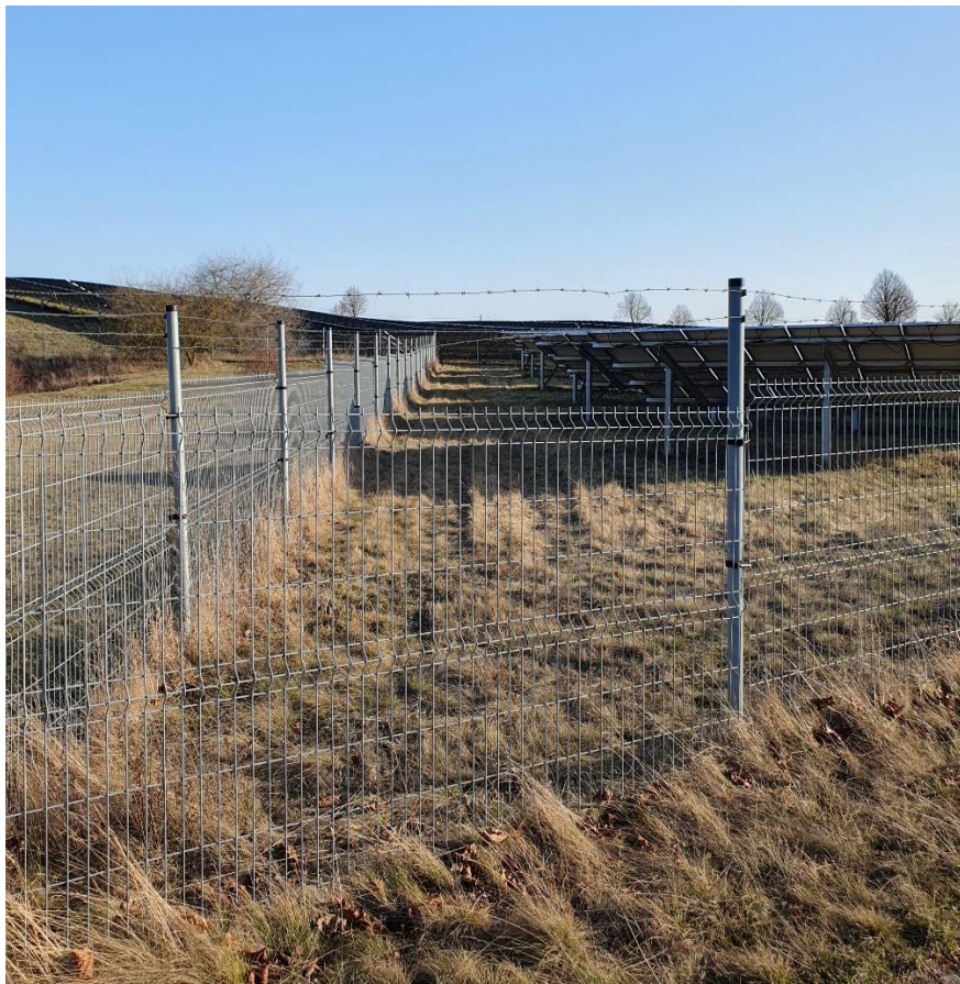
Abbildung 6: Einfriedungen ohne Abstand zur Geländeoberfläche 11
