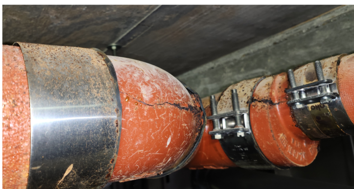
Detail zur Schädigung der SLM Rohrleitung
