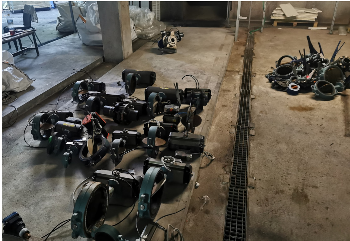
Übersicht der demontierten Klappen
