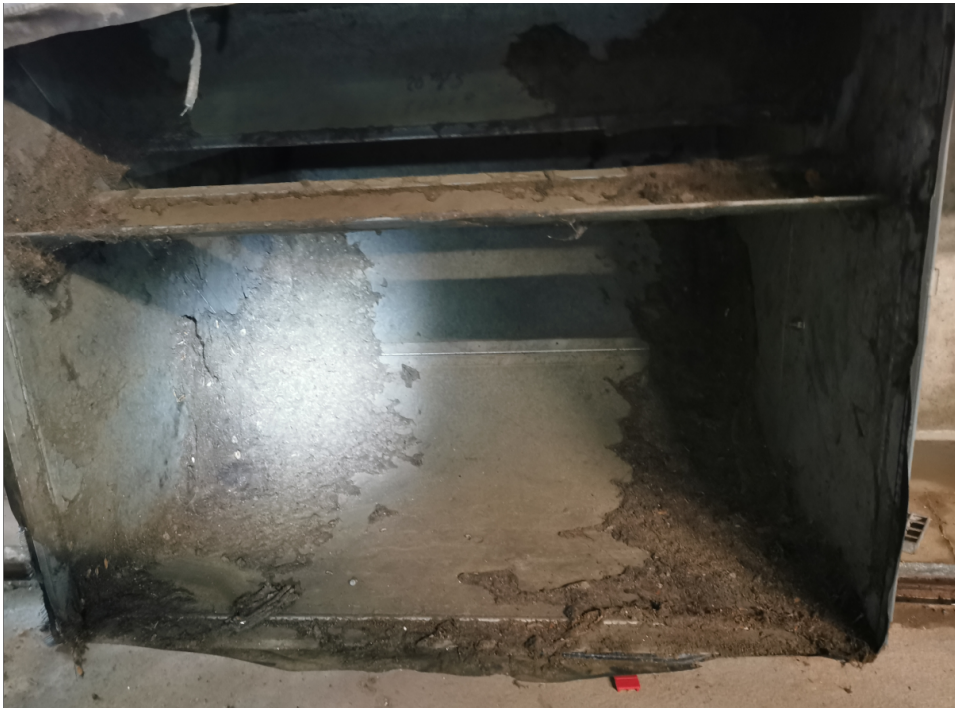
Geöffneter Lüftungskanal
