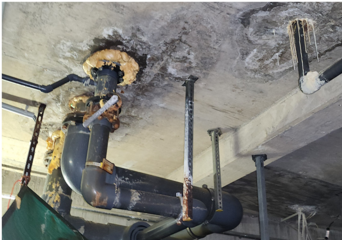
Der Beckenanschluß ist undicht, einschließlich der Anschluß-verroh- rung
