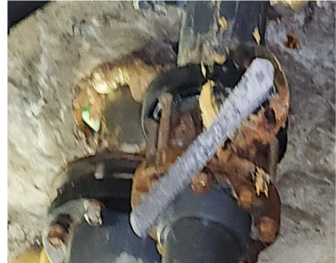
Der Beckenanschluß ist undicht, einschließlich der Anschluß-verroh- rung
